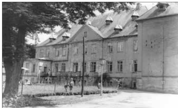
Außenstelle der Bezirksnervenklinik Schwerin in Dobbertin, Rückansicht Haus 16, Foto: Landeshauptarchiv Schwerin, Bestand: LHA SN 7.11-1/31 BNK Schwerin, Signatur: Nr. 83, S-2017-161-002
